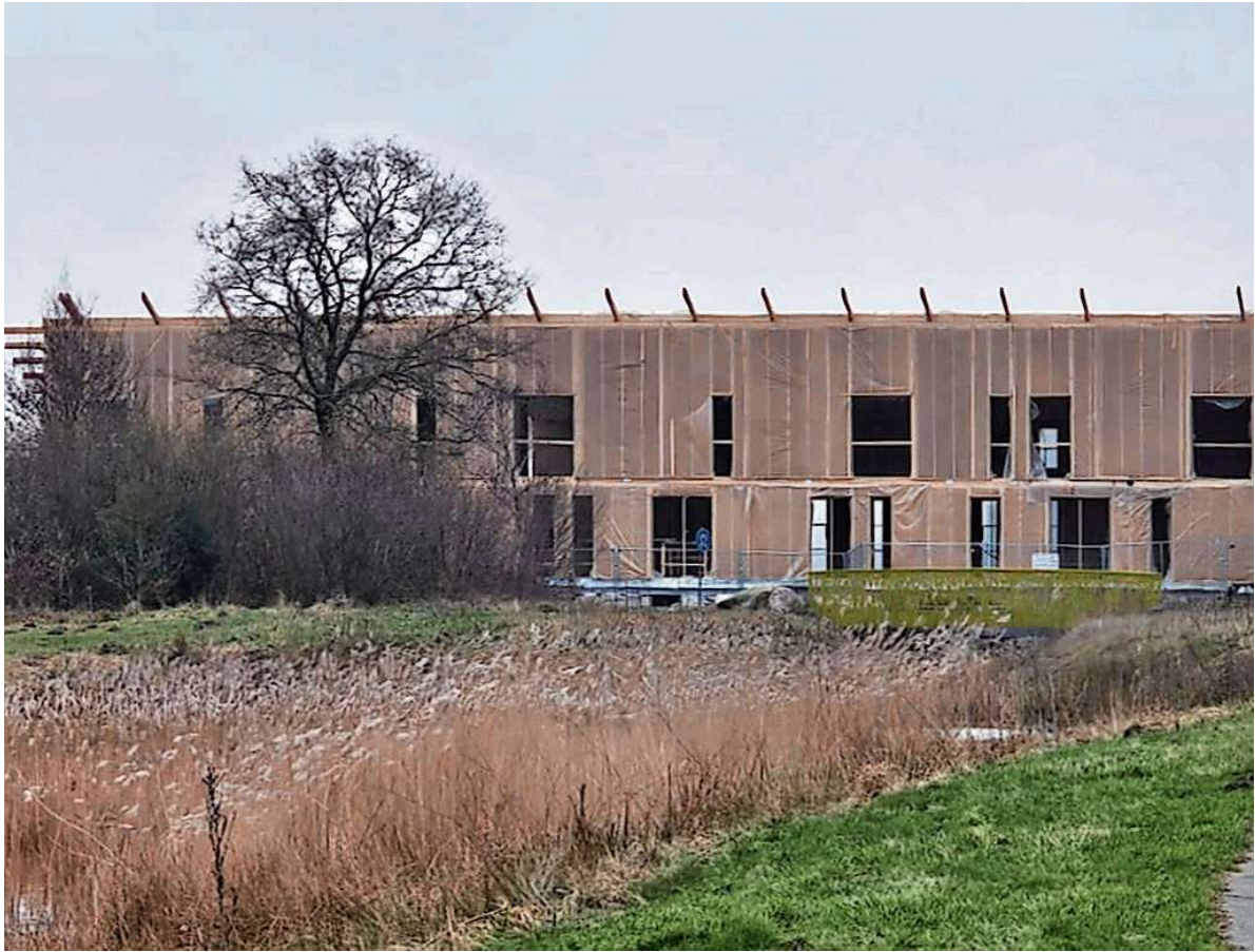
HET KANTOORPAND IN AANBOUW. AANGELEVERDE FOTO
